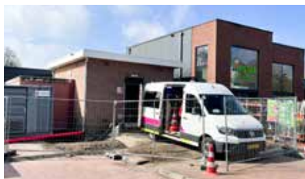
Aan de verbouwing van het elektriciteitshuisje naast de supermarkt wordt gewerkt. Maar wanneer dit gereed is, blijft voor Robin een vraagteken.
